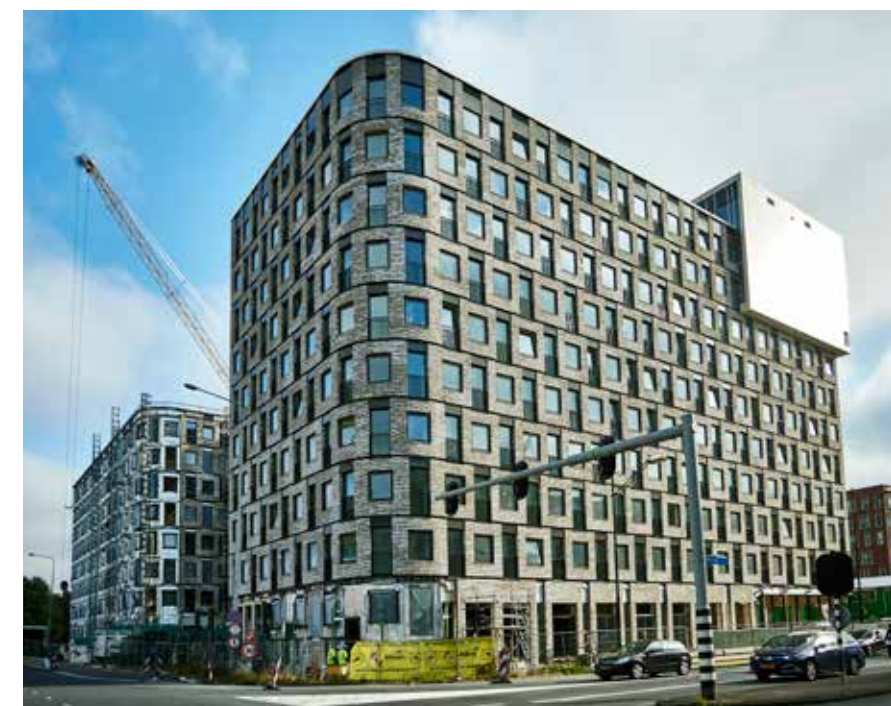
Gemetselde gevel nadert voltooiing.
