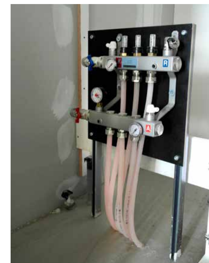
Afleverzet met pomp draagt zorg voor warmteverdeling.
