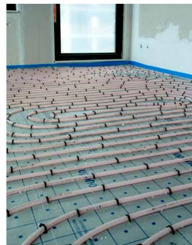
De vloerverwarmingsbuizen worden getackerd op de ondervloer.
